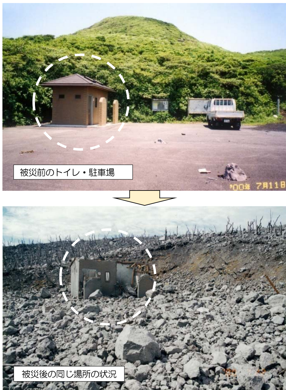
図 2-1 2 2000 年三宅島噴火による噴石被害状況
