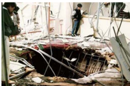
図 2-11 噴石被害の例 (火口から約 3.2 km地点)
