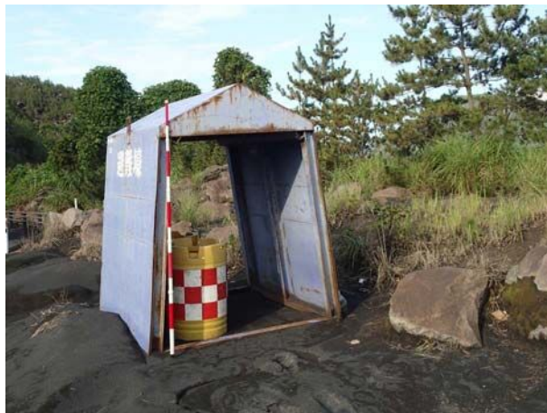
図 3-17 桜島の鋼製仮設退避壕
