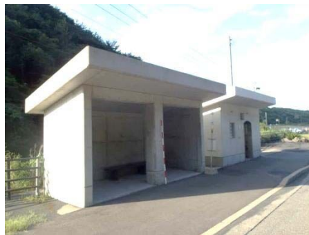
図 3-6 バス停として利用されている片屋根型退避壕（桜島）
